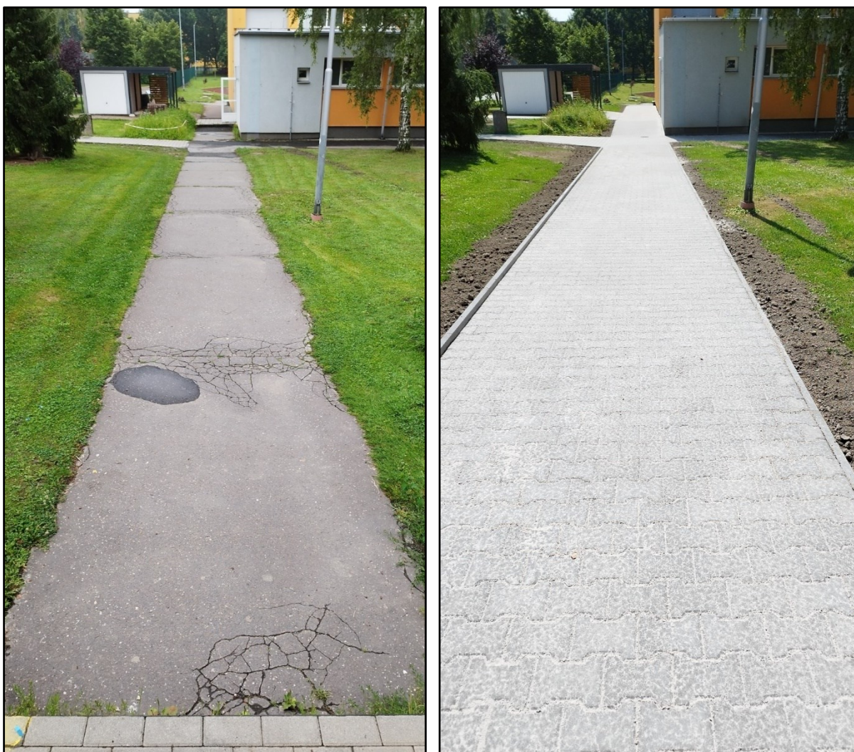
Chodník nově bezbariérově navazuje na objekt tělocvičny a školního hřiště.
