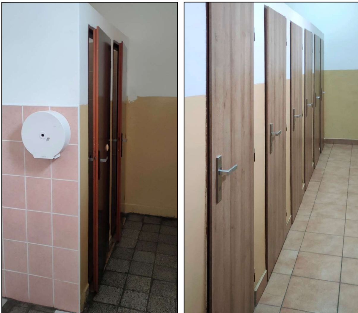
11 – Výměna dveří na sociálních zařízeních – původní a současný stav
