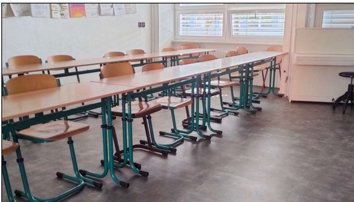
9 – Výměna PVC krytiny v učebnách
