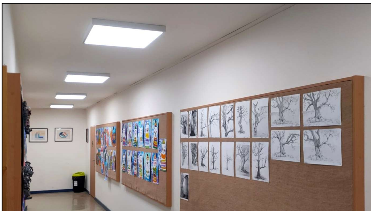
4 – Oprava osvětlení v chodbě u učebny výtvarné výchovy
