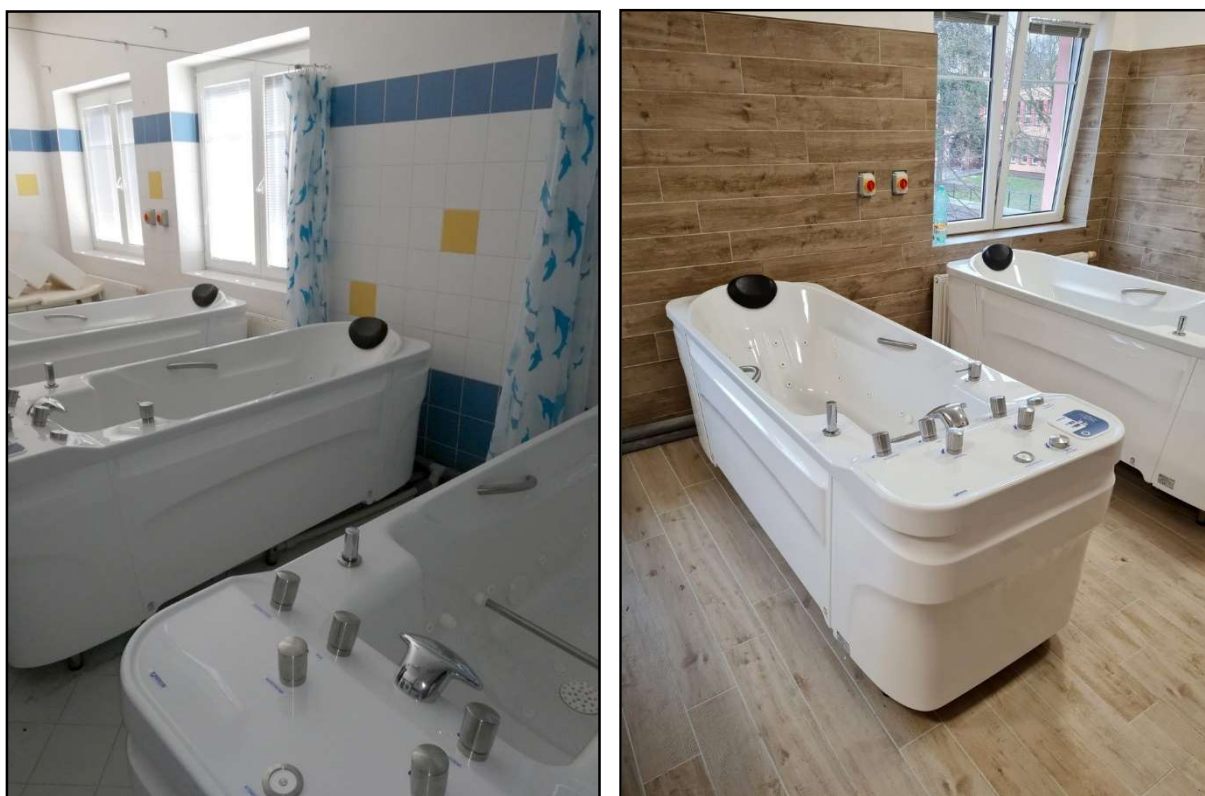
7 – Výměna celotělových regeneračních van včetně rekonstrukce podlah, obkladů a osvětlení
