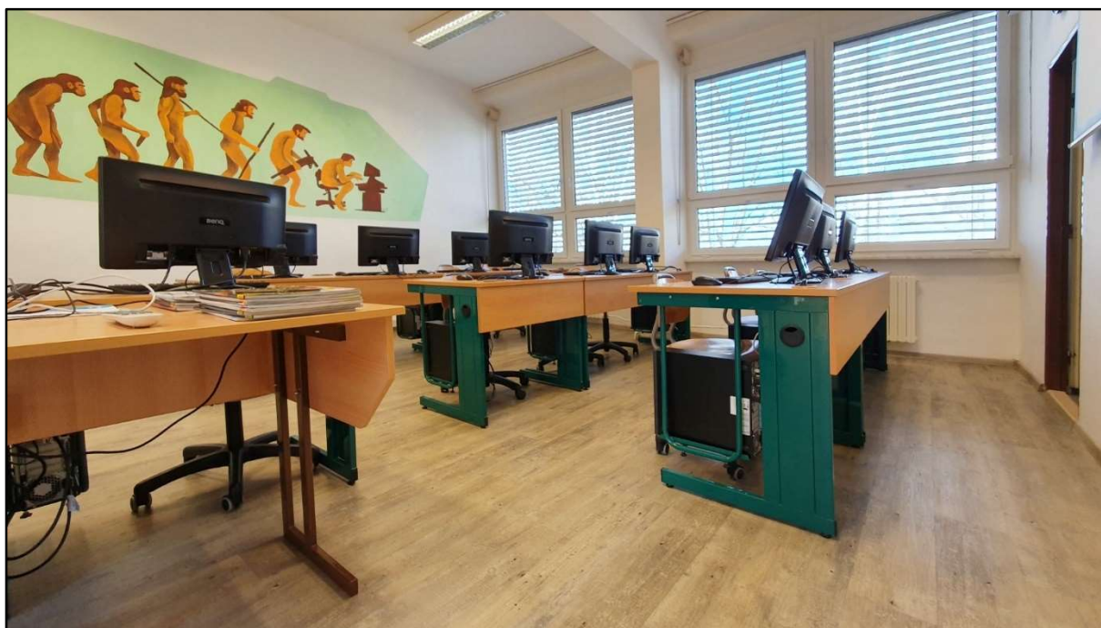
9 – Výměna PVC krytiny v učebnách
