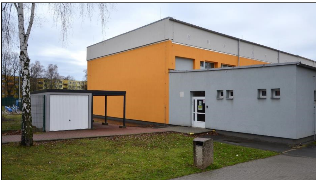
6 – V roce 2019 byla provedena rekonstrukce střechy tělocvičny, pro ukládání sportovního vybavení postaven kontejnerový sklad.
