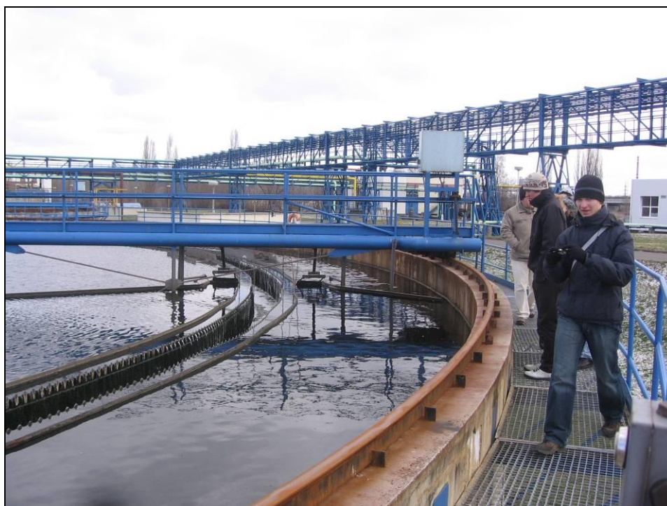
Obr. 3 Čistička odpadních vod v Ostravě – Přívoze.
