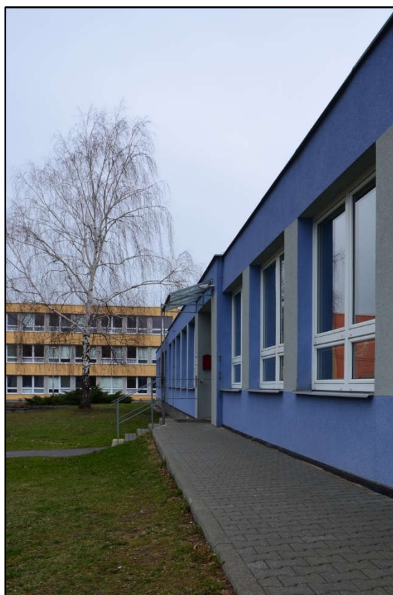
8 – Bezbariérový chodník k hlavnímu vchodu do školy
