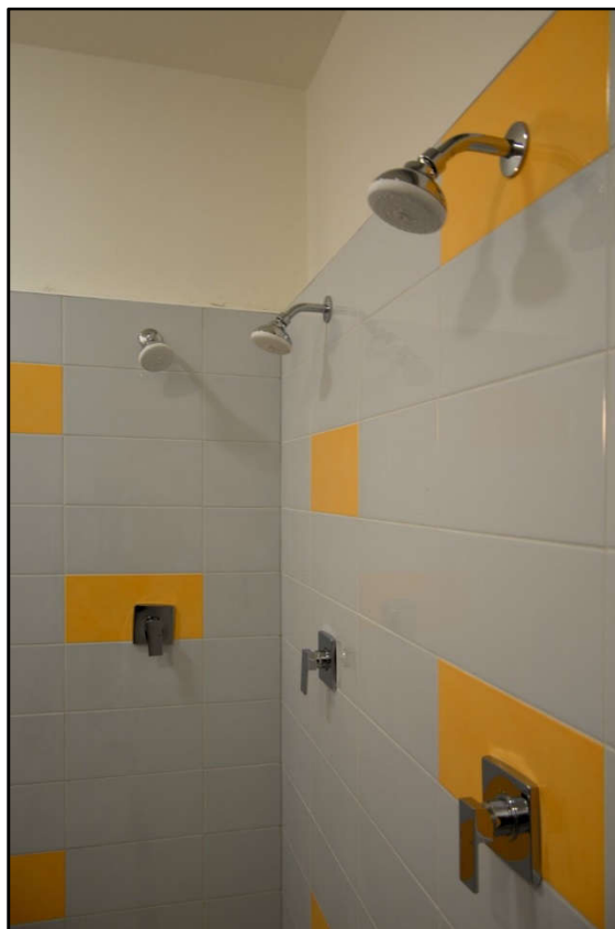
7 –Oprava umývárny v šatně správní budovy sportovního areálu
