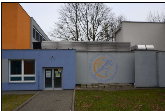
5 - Výměna kompresoru vzduchotechniky na střeše spojovací budovy pro školní kuchyň
